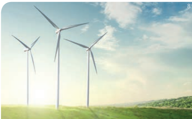
Windkraftanlagen – Beispiel für Bauteil aus GFK: Rotorblätter
